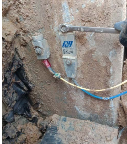
รูปที่ 21 การติดตั้งอุปกรณ์ทั้ง 2 อย่าง บริเวณด้านข้างเสาเข็ม
